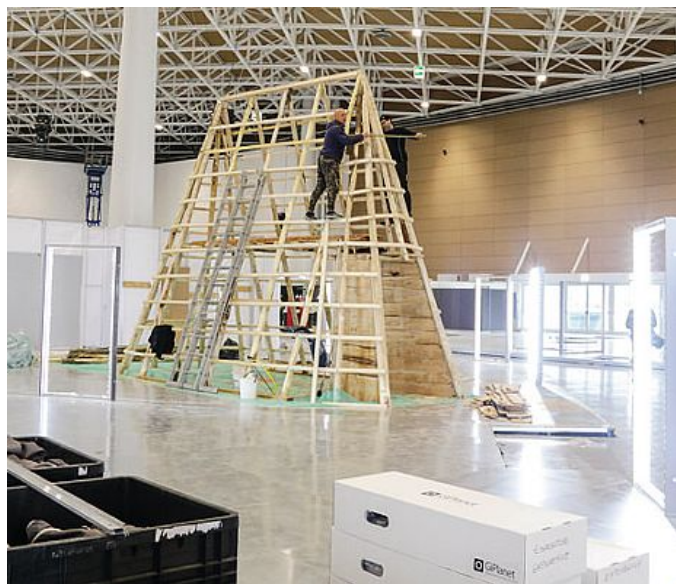
L'interno del Padiglione Aquae in allestimento
